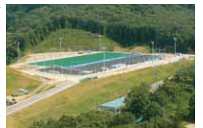
▲建設中のホッケー場
